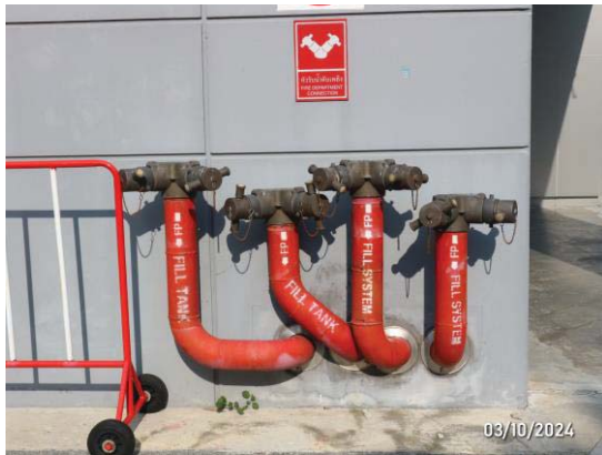
รูปที่ 3-46 หัวรับน้ำดับเพลิงภายนอกอาคาร
