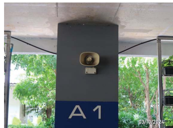
รูปที่ 3-56 ลำโพงแจ้งสัญญาณเตือนอัคคีภัย (Alarm Horn With Strobe Light)
