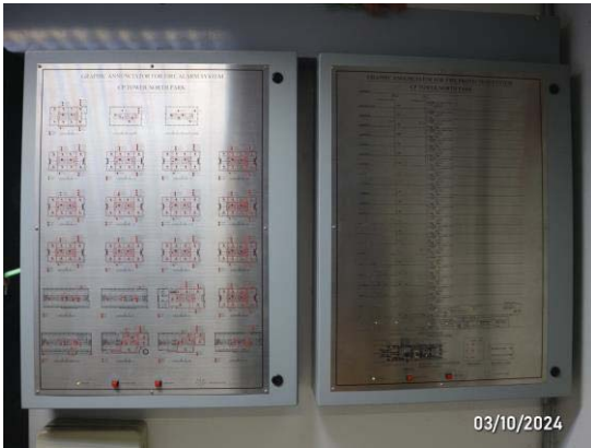
รูปที่ 3-52 แผงควบคุม (Fire Alarm Control Panel : FCP)
