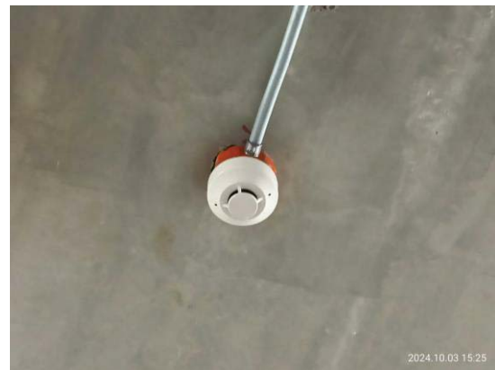
รูปที่ 3-40 เครื่องตรวจจับควัน (Smoke Detector) ภายในห้องหม้อแปลงไฟฟ้า
