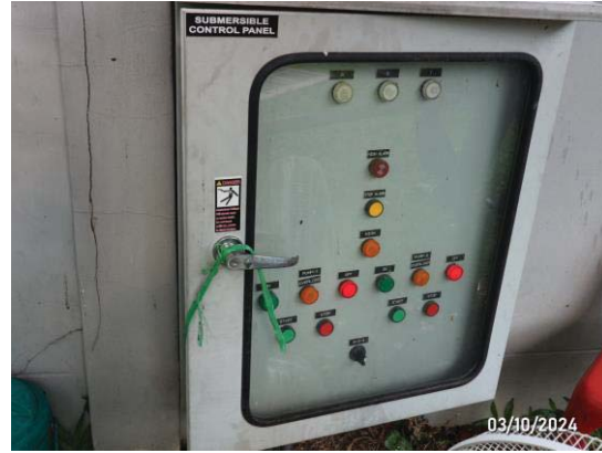
รูปที่ 3-27 ตู้ควบคุมเครื่องสูบน้ำ
